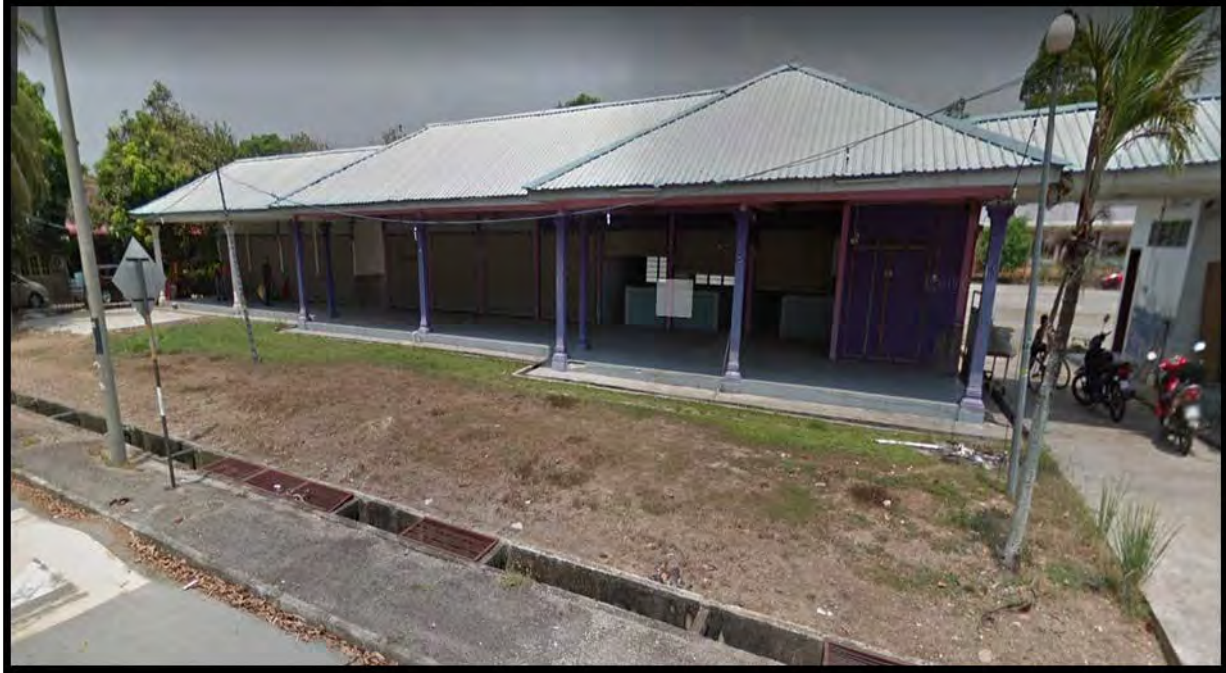
➤ JALAN HADAPAN KOMPLEKS MAKANAN BERTAM INDAH, SPU
