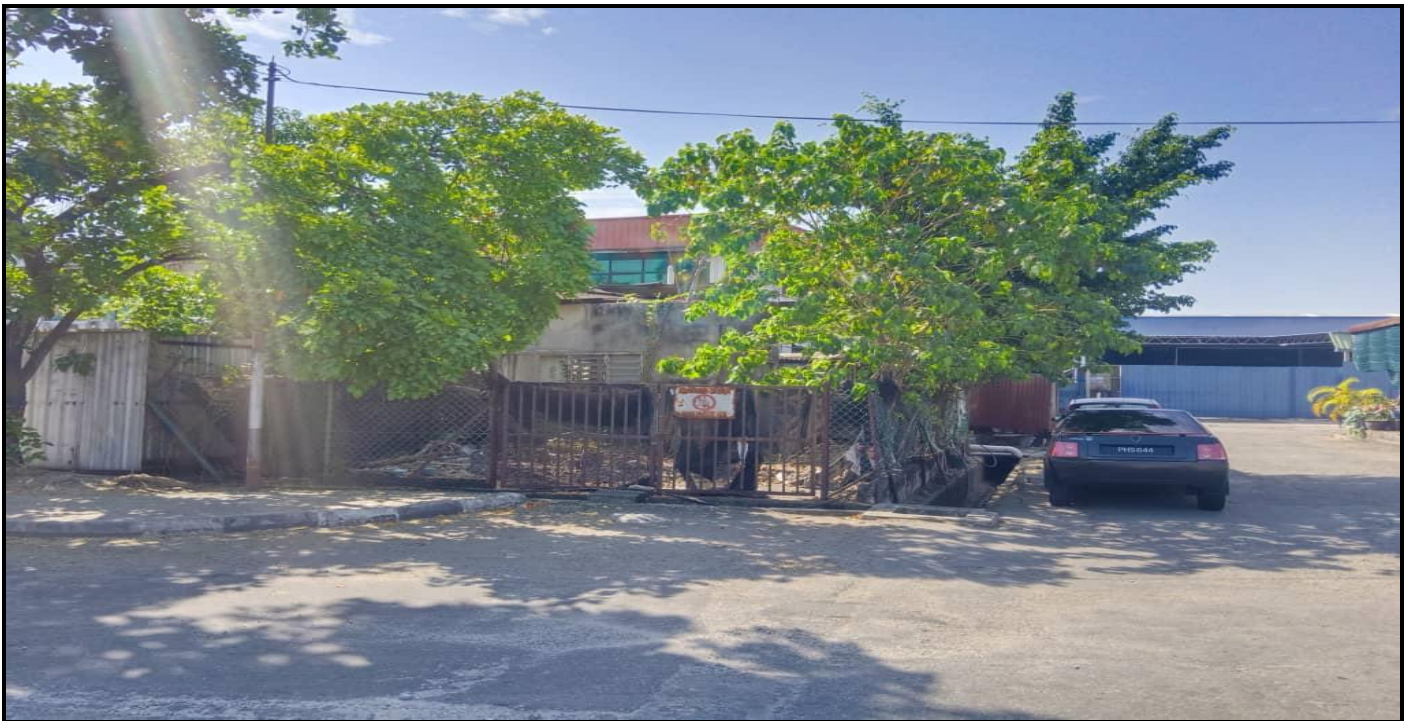
GAMBARFOTO BANGUNAN DEPO SAMPAH MILIK MBSP DI ATAS LOT 3197, MUKIM 13, TAMAN INDUSTRI BERINGIN, SPT
