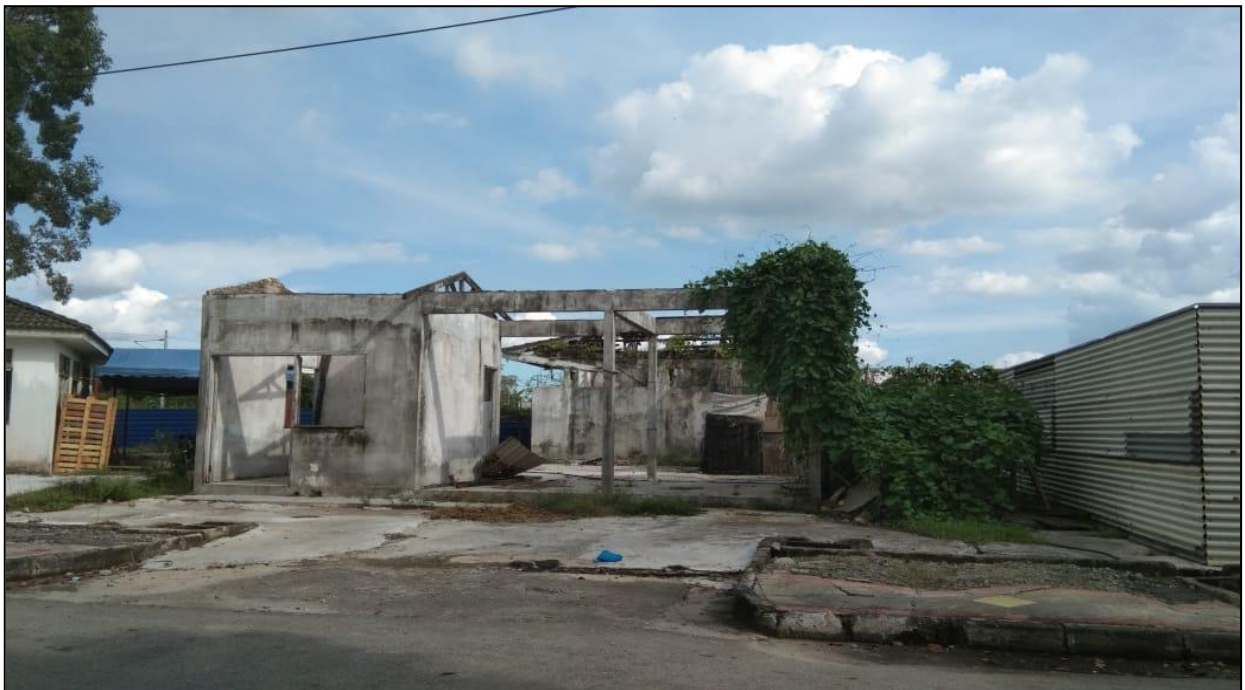
GAMBARFOTO BANGUNAN DEPO SAMPAH MILIK MBSP LOT 11094, JALAN PALA 8, KAWASAN INDUSTRI RINGAN PERMATANG TINGGI, MUKIM 14, SPT
