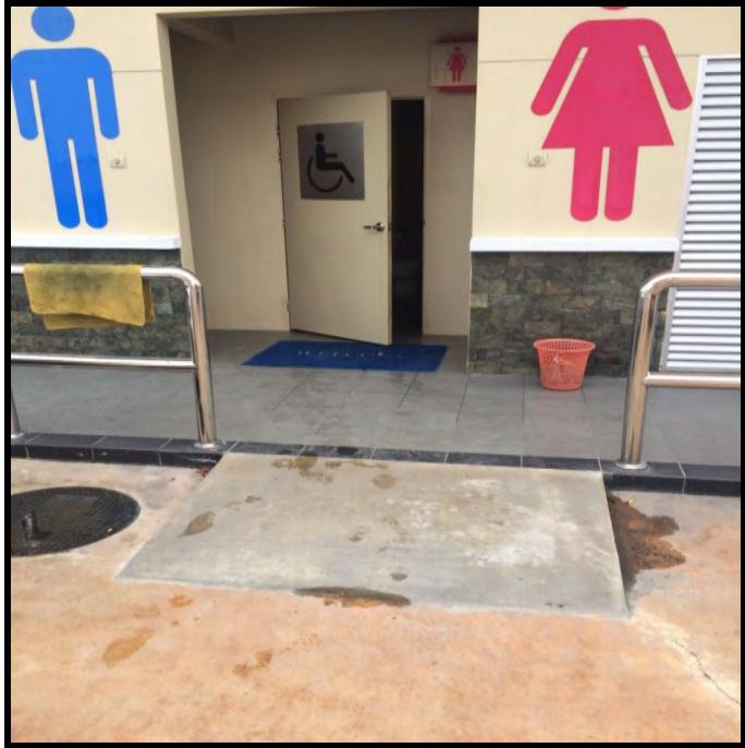
Pemasangan *ramp* tidak dibuat mengikut spesifikasi yang dibenarkan
