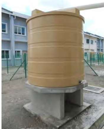
Foto 18 : Tangki Air Di Atas Tanah
