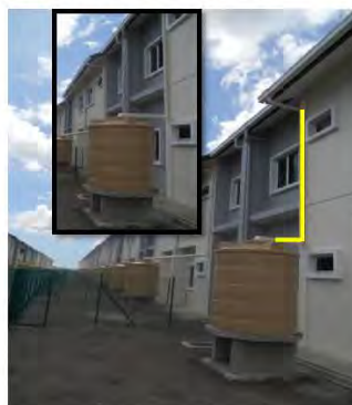
Foto 21 : Downpipe Berbentuk "L"
