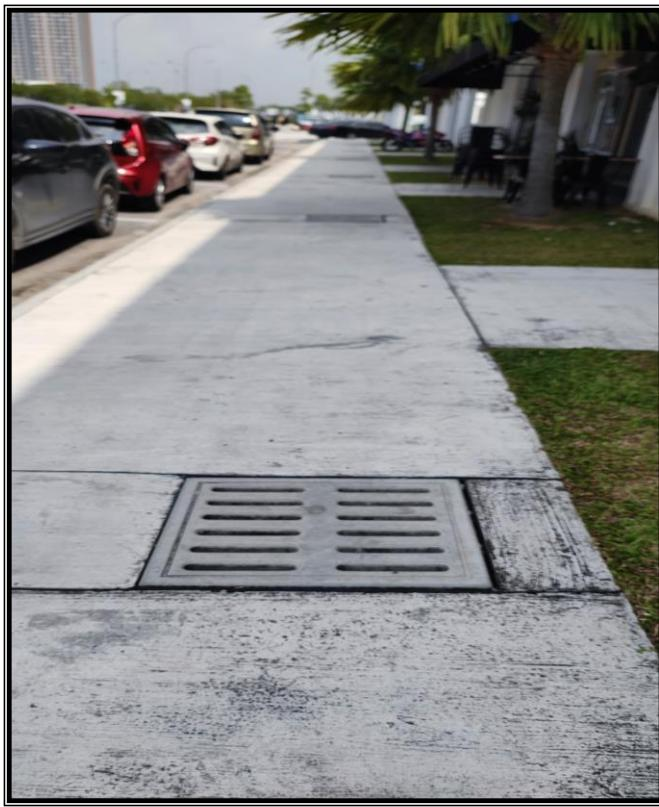
**Gambar E:** Parit Bertutup Dengan Lubang Penyelenggaraan Di kawasan Skim Komersial
