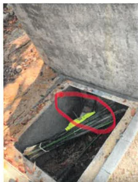
**Rajah 3** menunjukkan kedudukan manhole dan cable trench untuk kabel TNB
