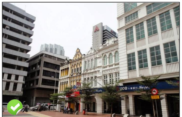
Gambar 33 : Pemasangan papan iklan yang tidak menutup façade bangunan.
