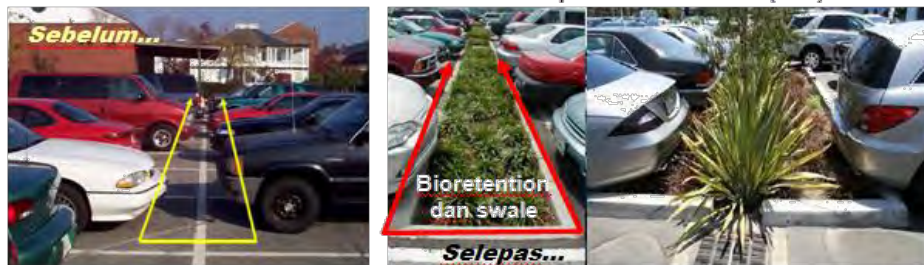
Bioretention di sepanjang sisi jalan
