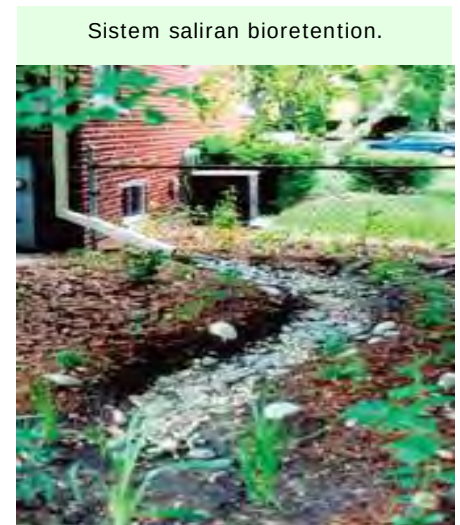
Rajah 35 : Konsep bio-retention (sebagai penapis dan penyerap air larian permukaan) di kawasan pembangunan
