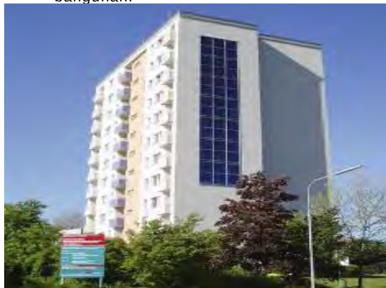
Foto 21 : Contoh facade collector system yang dipasang sebagai sebahagian daripada fasad bangunan.
