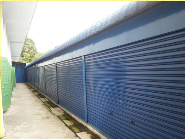
Ruang parkir basikal diubah suai untuk dijadikan stor perabot
