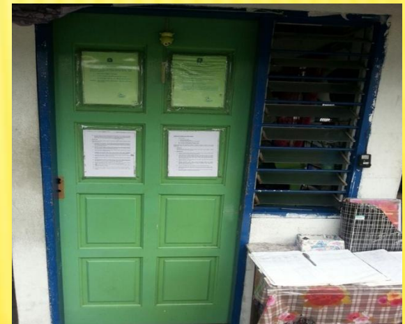
Pintu dewan digunakan untuk menggantikan pintu guard house
