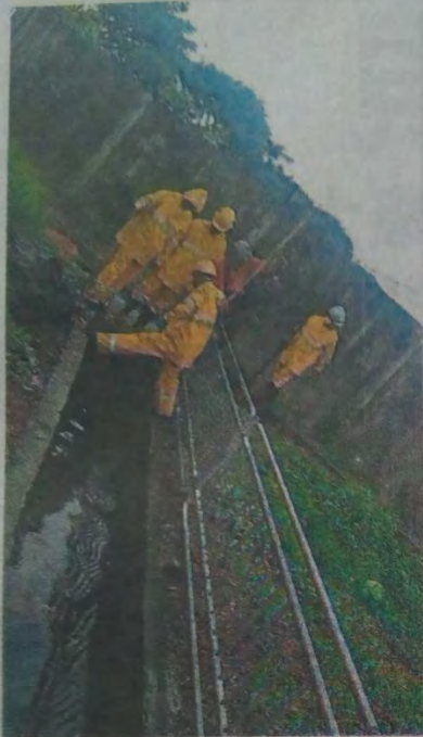
▲ 市政局清洁工人冒雨清理排水道的垃圾。
