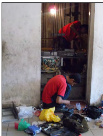
Gambar 1.11 Kerja Pembaikan kecil dan penyelenggaraan lif
