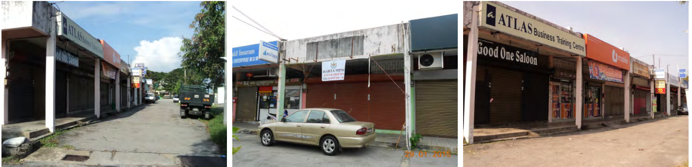
Gambar 1.3: Bangunan milik Majlis disewakan di Jalan Mohd Saad, Butterworth, SPU
