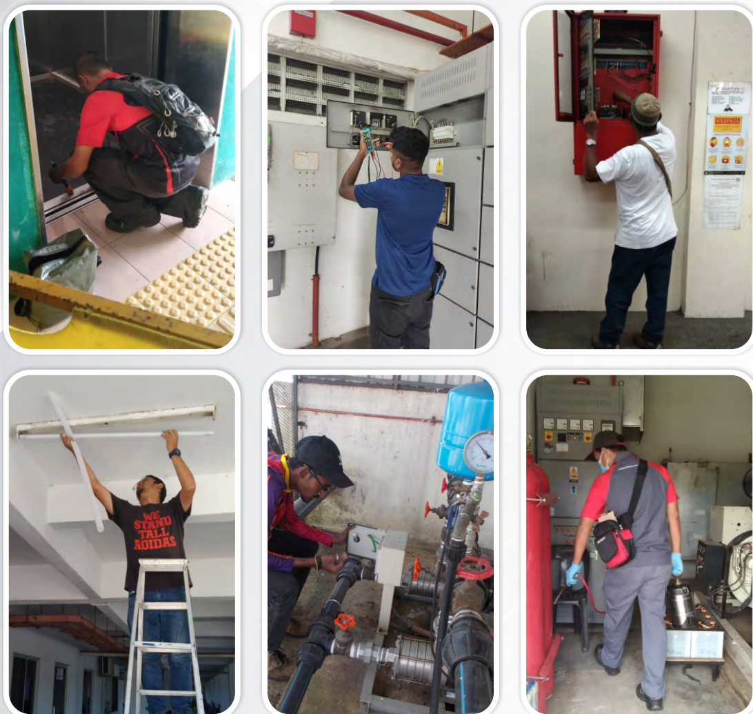
GAMBAR 3 : KERJA-KERJA PENYELENGGARAAN RUMAH PANGSA PPR AMPANGAN
